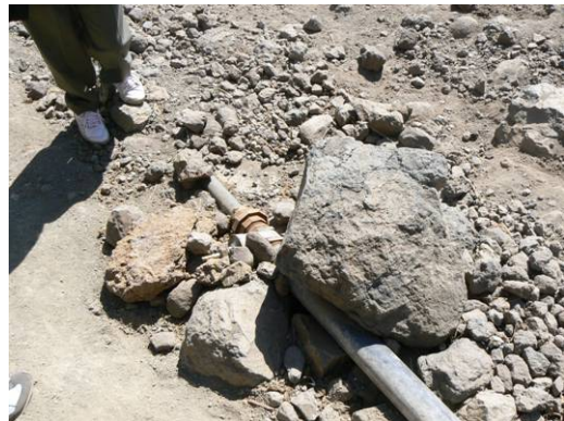
↑ ↓カンカニラインの架設状況 (下は2インチパイプと3インチ パイプが接続されているところ)
