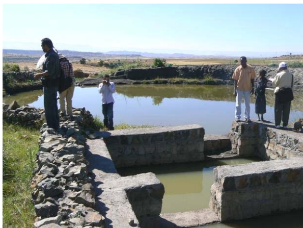
沈砂池（手前）と溜池
