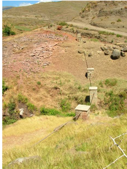
↑ ↓カンカニラインの架設状況 (下は2インチパイプと3インチ パイプが接続されているところ)
