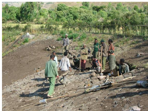
住民による改修工事
