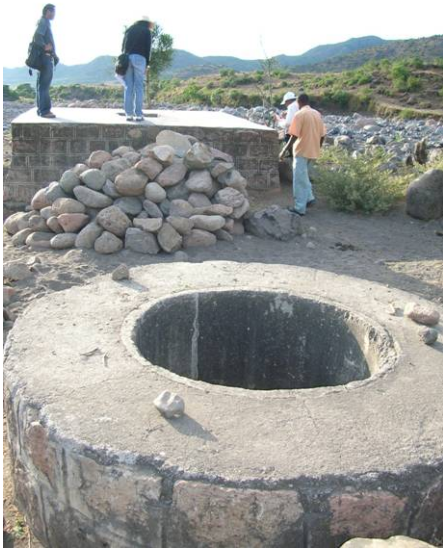
メダゲの水源で過去に設置された 簡易フィルター (手前) と貯水タンク
