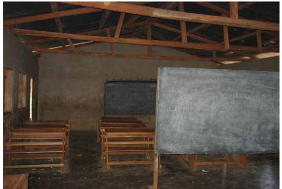
教室内部 (大部屋形式で、黒板で間仕切り)
