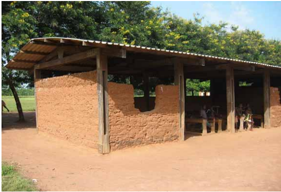
パビリオン形式の教室棟 (外壁がない部分がある)
