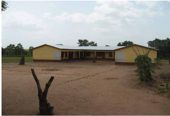
U字型配置の6教室棟外観 (教育省FPMUによる標準設計)
