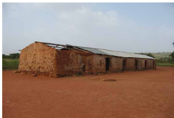
土壁造の6教室棟の外観
