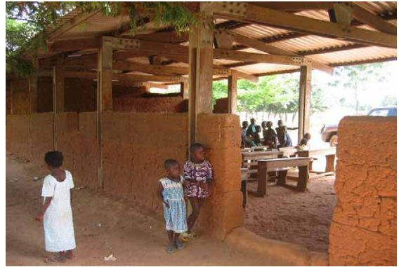
腰高までの外壁(土壁) (木造柱・トラスが堅牢)
