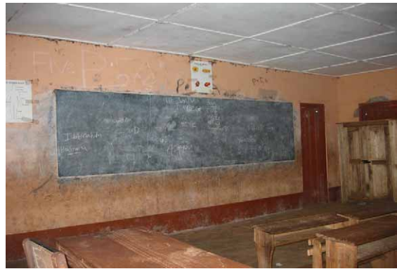
教室内部(天井仕上げあり)
