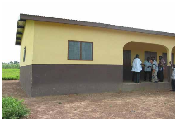
2007年に完成した3教室+校長室・倉庫棟
