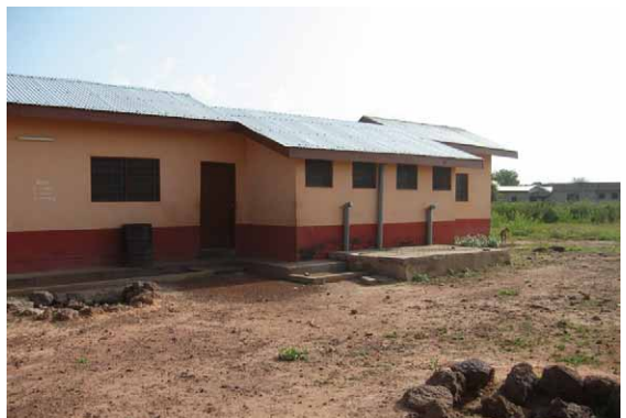
背面 (厨房、トイレ、シャワー室部分)
