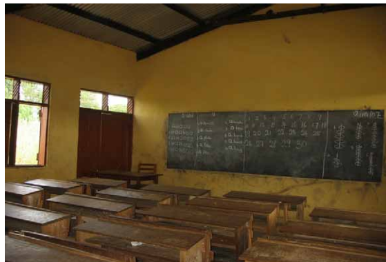
教室内部 (天井仕上げなし)
