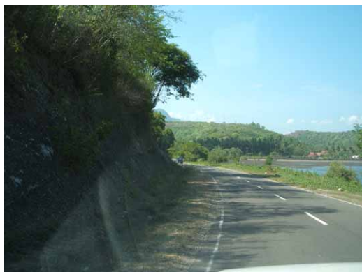
国道 028.1 号 アスコン舗装 幅 6.0m
