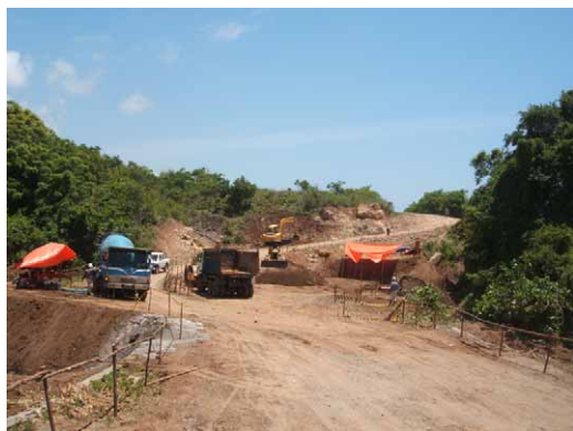
Tanaman I 橋梁 下部工施工中
