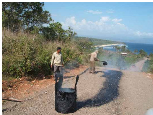
道路改良工事（マカダム舗装）州道 069.4 号
