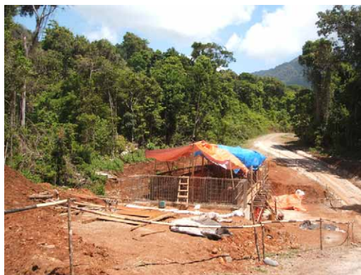
Tabisu IV 橋梁 上部工施工中
