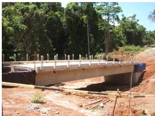
Tabisu III 橋梁 橋梁完了
