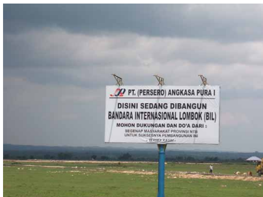
国際空港 建設中 全景（ロンボック島南側）
