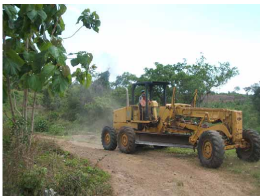
道路改良工事（路床整正）州道 069.4 号
