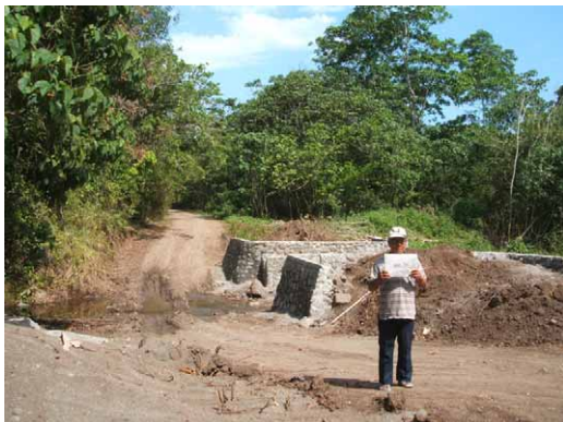
BR-26 Krikrit 橋梁 建設中
