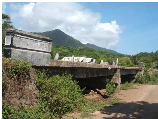
Brunt 橋梁 州道 069.4 号 2008 年架替予定
