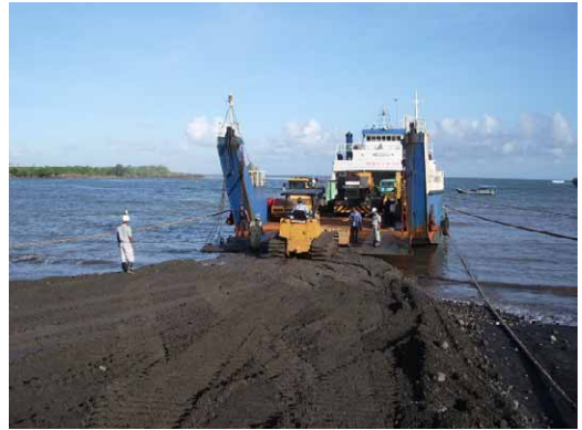
LTD より同左地区での重機荷揚げ NTB 橋梁建設計画第 1 期における
