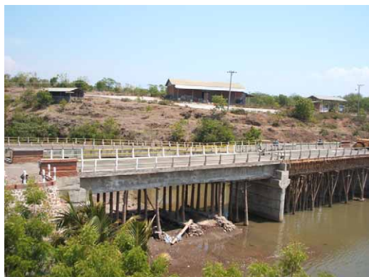
橋梁架け替え工事 Slayar 橋梁 州道 062 号（ロンボック島南東部）
