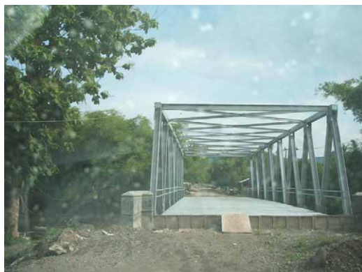
橋梁架け替え工事 Jereweh 橋梁 州道 044 号
