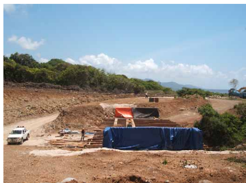
Tabisu II 橋梁 上部工施工中
