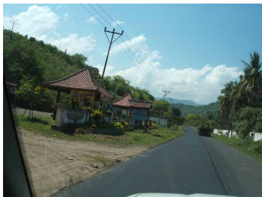
道路修繕工事（オーバーレイ）国道 028.1 号
