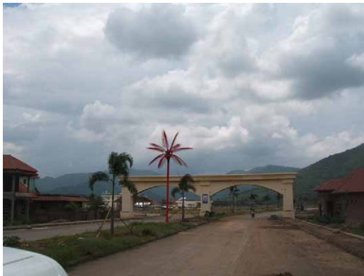
西スンバワ県新庁舎建設中（Taliwang 市）
