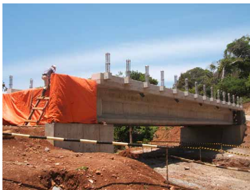
Puna III 橋梁 橋梁完了間近
