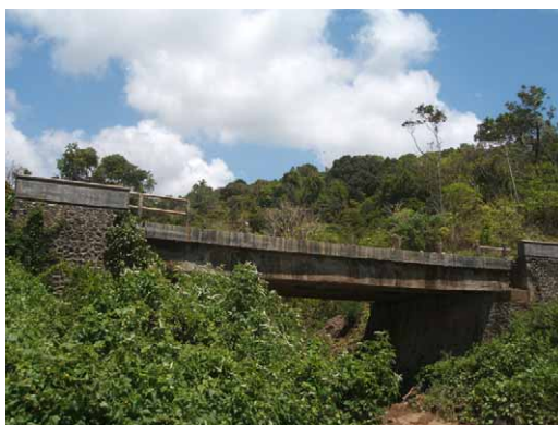
Tabisu II 橋梁 2008 年施工予定 上部工のみ改修
