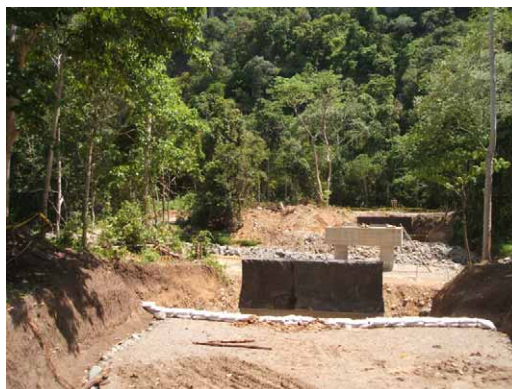
Tongolaka 橋梁 下部工完了
