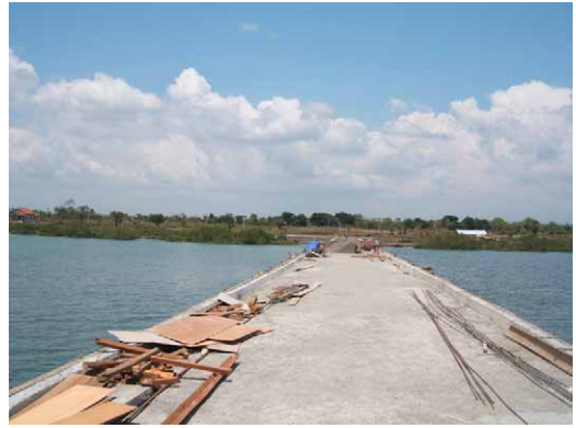
Telong-Elong 港 建設中 後背地にはターミナル建設予定
