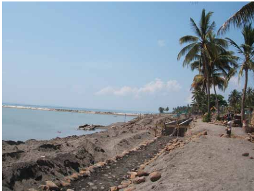
Haji 港 建設中（ロンボック島東側）
