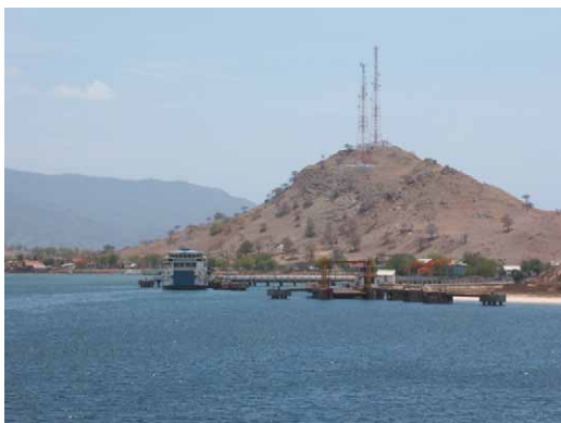
Tano 港 全景（スンバワ島北西側）
