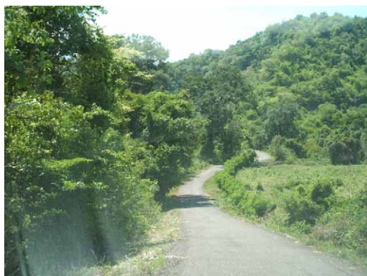
州道 047 号 アスコン舗装 幅 4.5m
