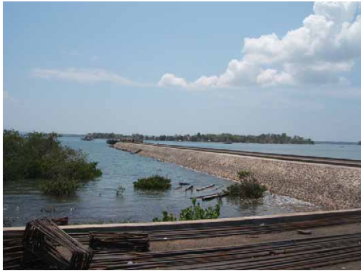
Telong-Elong 港 建設中（ロンボック島南東側）
