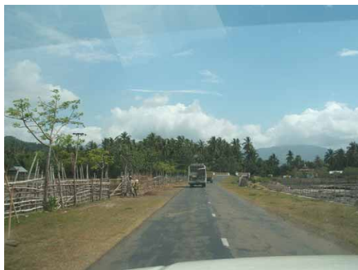
国道 044 号 アスコン舗装 幅 4.5m
