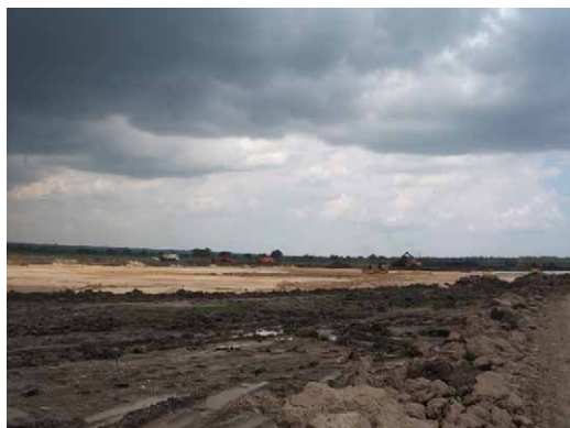
国際空港 建設中
