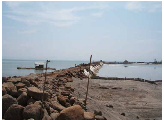
Haji 港 建設中
