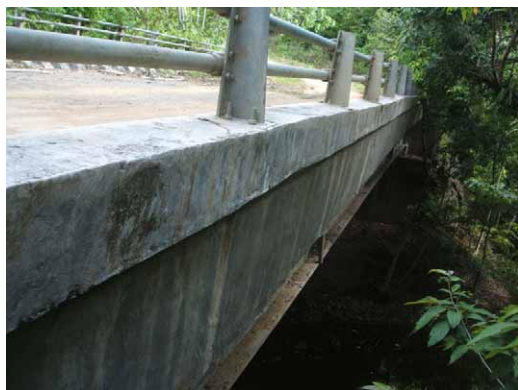
Sanyur IV 橋梁 州道 069.2 号 鉸桁橋梁
