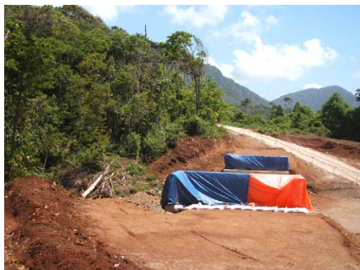
Tabisu V 橋梁 下部工完了
