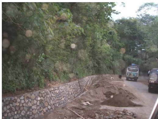
道路修繕工事（路側側溝）州道 038 号
