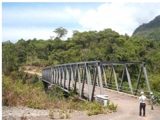
Puna II 橋梁 州道 069.4 号 2006 年完成
