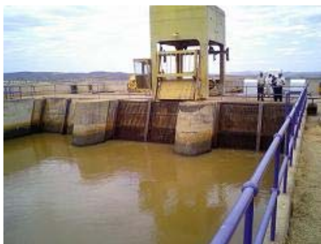
キンダルマダム取水口（幅約 20m）
