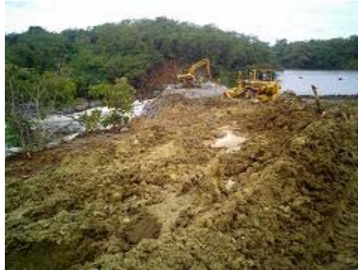
ダム建設サイト
