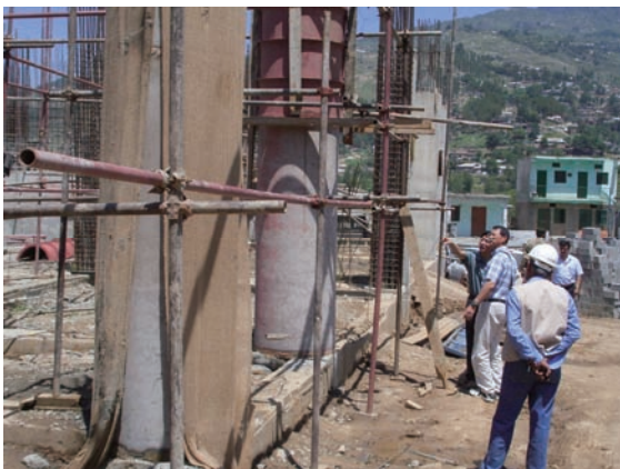
DHQ 病院の再建現場
