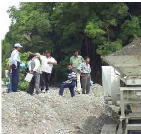
河川敷の路盤材の採取 (現地セミナー)
