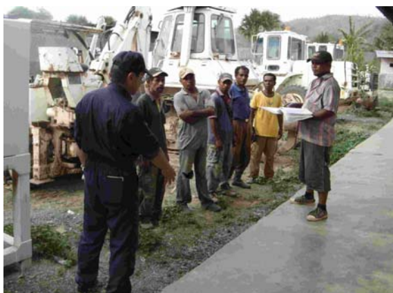
オペレータへの現場実習前の 事前説明
