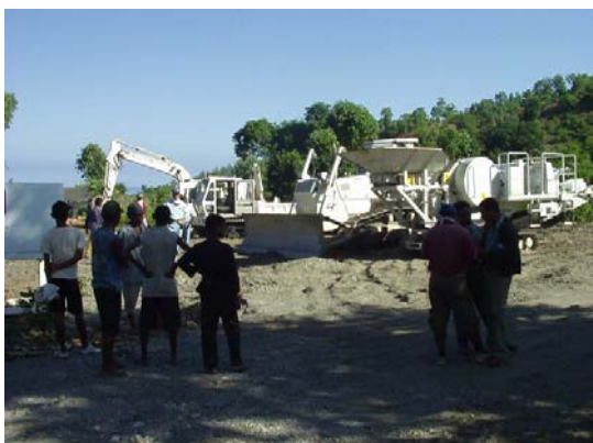
建機操作前の作業点検
