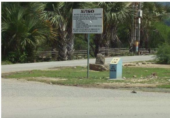
「東ティ」国全幹線道路(総延長 1,400 km)へのKm ポストの設置
