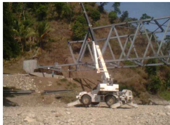
IGE所有のクレーンを使用した 橋梁工事現場
