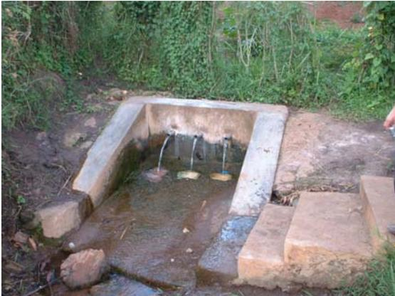
Rwamagana 郡：給水施設①Mwulire の水源（保護湧水）。直ぐ近くに家畜の水飲み場を併設している。
