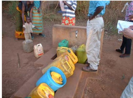
Kayonza 郡：給水施設⑩Rwinkwavu の近傍にある既存配管施設末端部。漏水が多く、ほとんど水が出ていない。現在は無料。クリソ財団が改修予定。
