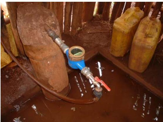
Kirehe 郡：給水施設⑨Kirehe。公共水栓。Tap Keeper がいて 20Frw/20 リットルを徴収している。そして、メーターに従って、郡レベルの組合にお金を支払っている。
