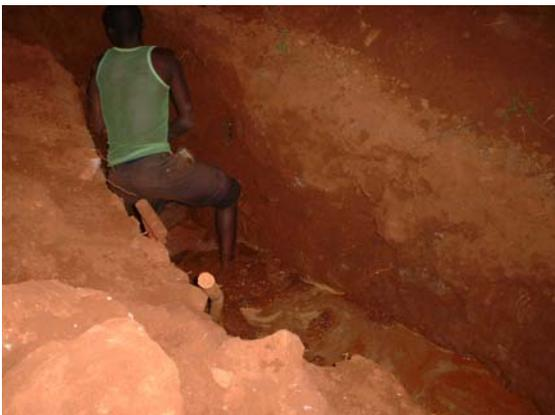
Kayonza 郡：給水施設③Rwinkwavu。1988年日本の無償案件にて建設。水利用組合が雇った水技師が漏水の修理を行っている。
