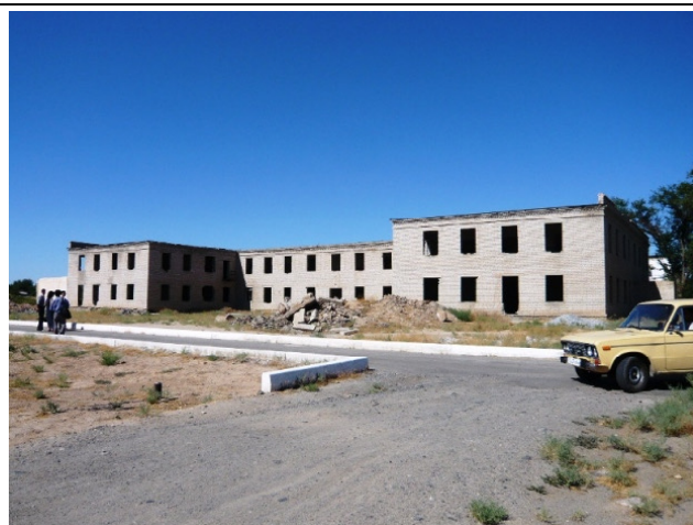
Новое здание, строительство которого завершится в 2008 году.
