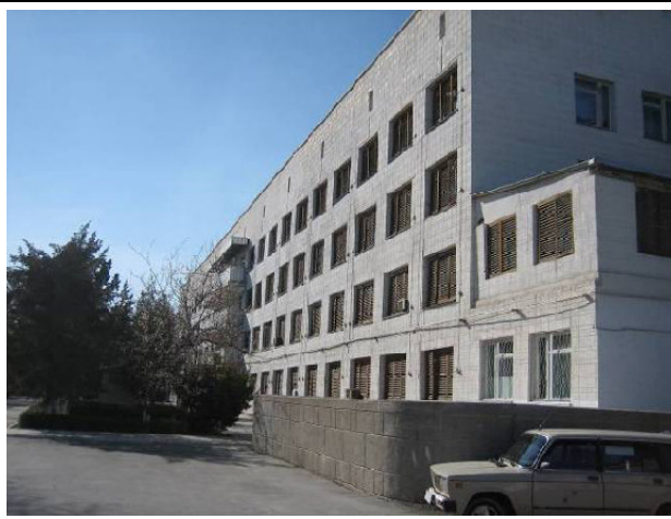
Главное здание, 4-х этажное
