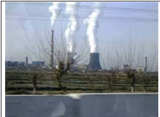
ナボイ市の火力発電所
