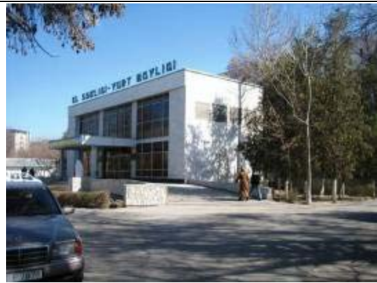
州救急センター： 本棟入口
