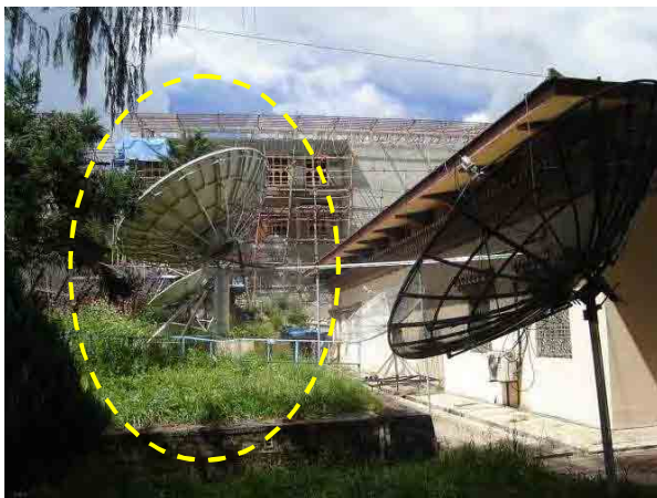
衛星伝送用送信アンテナ
