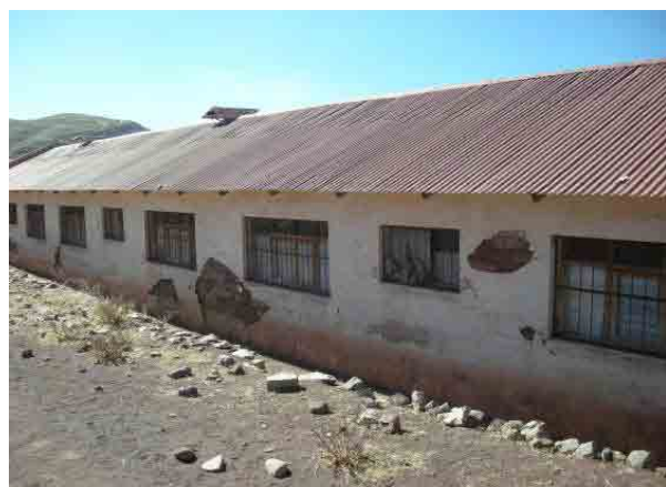
S-11 : Maranua校 クラックとモルタルの剥離が目立つアドベ造の校舎
