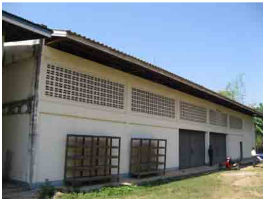
サバナケット県倉庫外観
