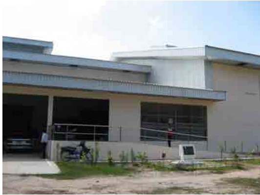
ロジスティックスセンター外観
