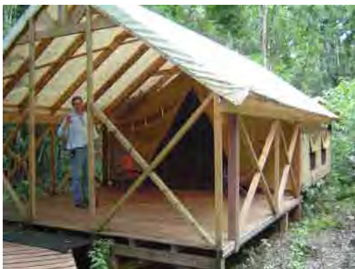
パイロット・サイト宿泊棟
