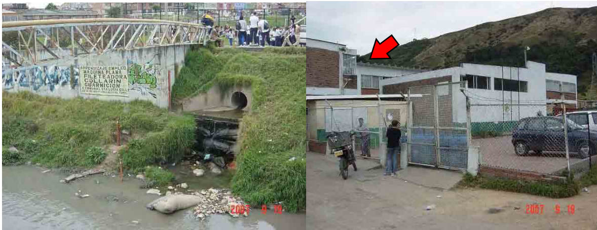
Foto S8-2-5 Limnómetro (izq.) y Caseta de seguridad del Colegio para el Data Logger
