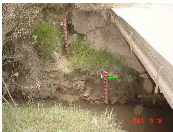
Foto S8-2-23 Instalación del nivel del Electrodo del Sensor de nivel de Agua
