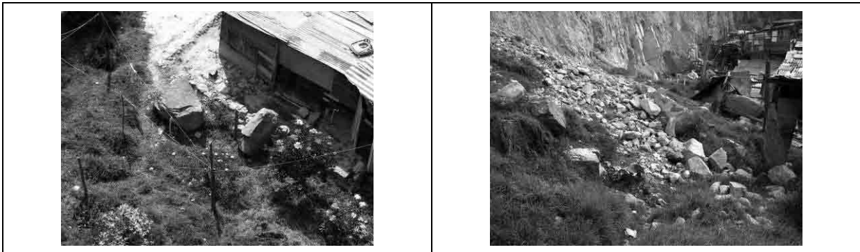
Foto S5-2-2 Caída de Rocas de Talud Empinado
