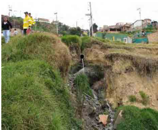
Foto S5-1-4 Flujo de Agua dentro del Deslizamiento
