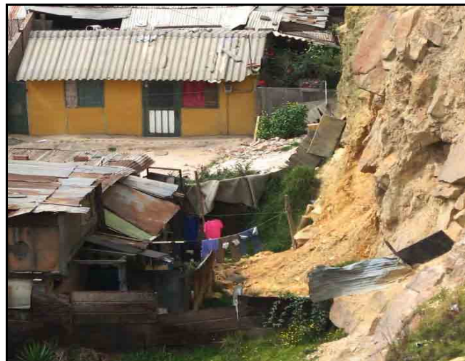
Foto S4-2-2 Casas construidas en la Base del Talud de una Mina Antigua y que esta Encarando Amenaza por Deslizamientos
