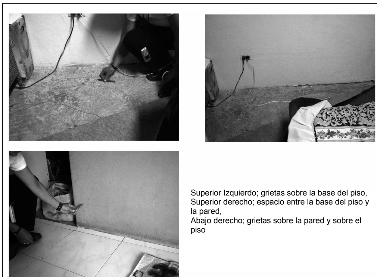
Foto S5-1-3 Deformaciones encontradas en la Casa
