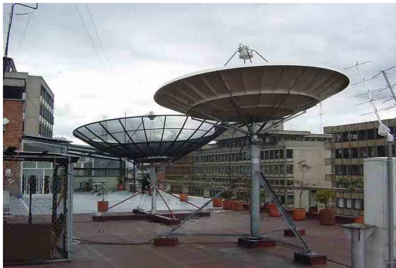
Figura S2-2-7 GOES Antenas en el Techo del IDEAM
