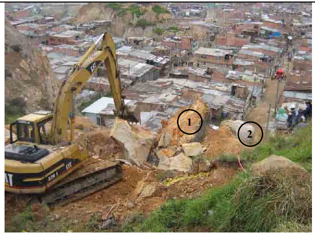
Piezas remanentes del bloque No.1 se remueven con retroexcavadora
