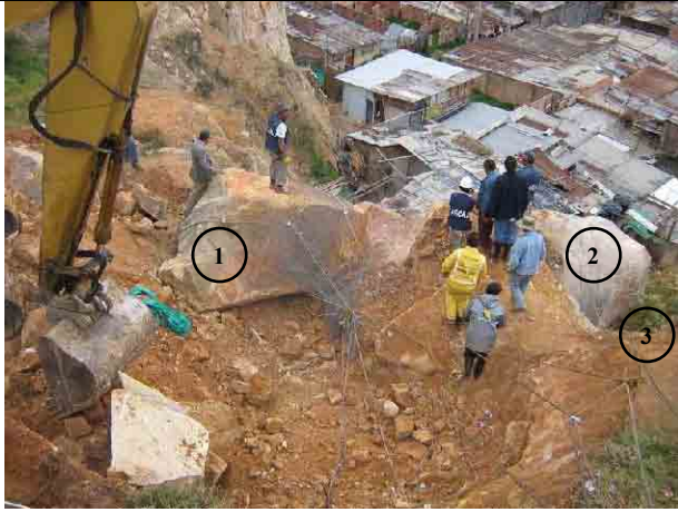
Terminación de las Medidas de Emergencia para el bloque No.1
