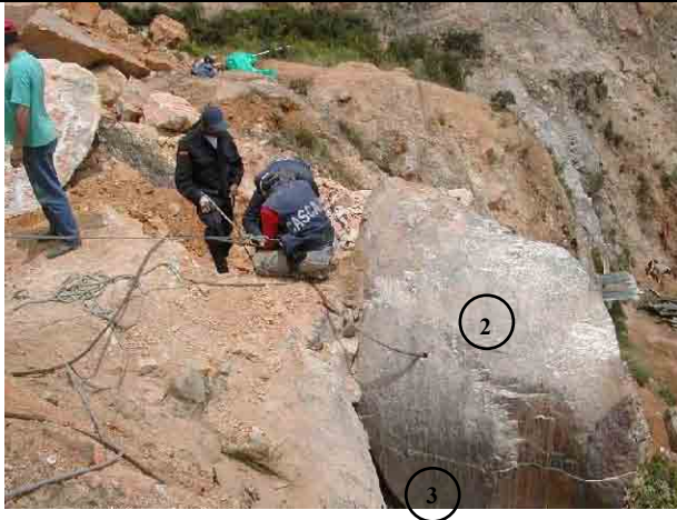
Instalación de guaya para los bloques No.2 y 3
