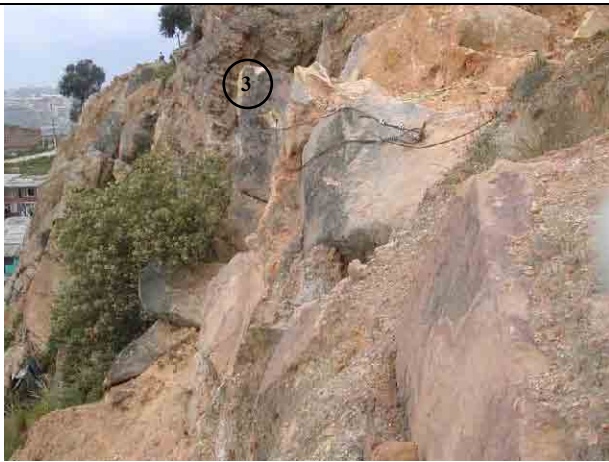
Instalación de guaya para los bloques No.2 y 3
