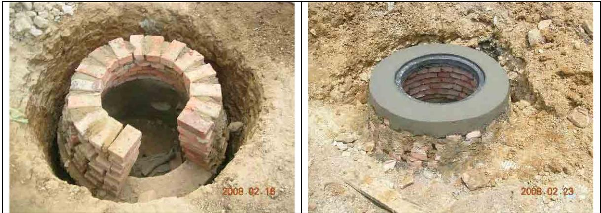
Figura 11-21 Estructura del Pozo de Drenaje
