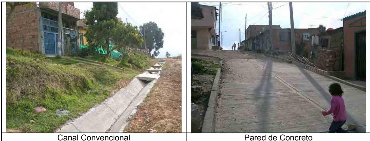
Figura 11-22 Canal Convencional y Pared de Concreto para ser un Camino de Agua en la Estación lluviosa
