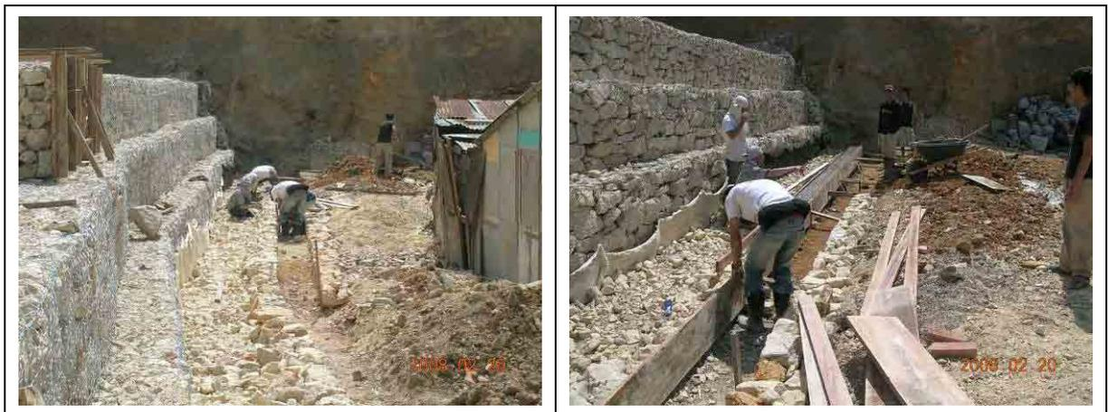
Figura 11-20 Fijando la Piedra Rajón con Concreto
