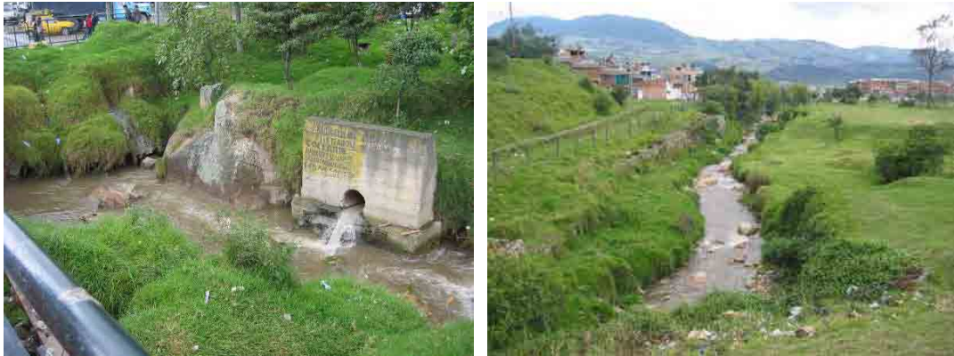
Foto 6-2 Punto 9 de Monitoreo DPAE "Quebrada Yomasa"
