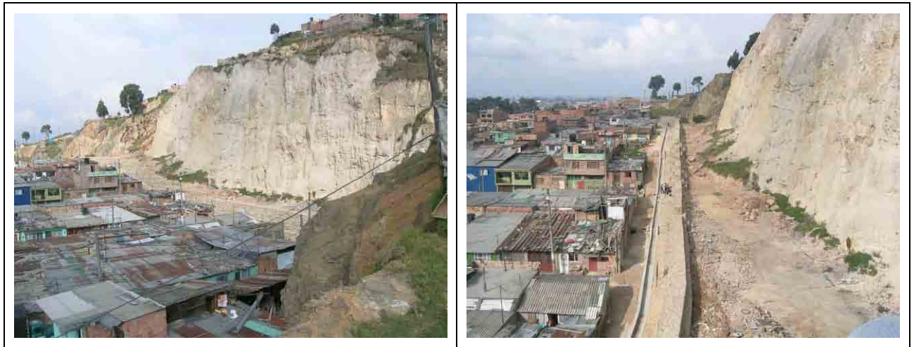
図 13-6 仮設工全景写真
