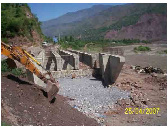
PC 桁架設状況
