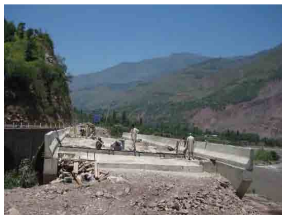
上部工施工状況
