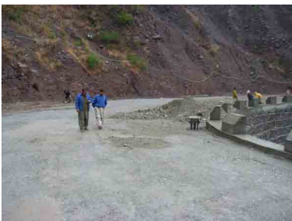
路盤工施工状況
