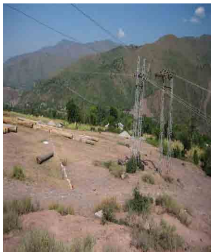
斜面掘削前状況
