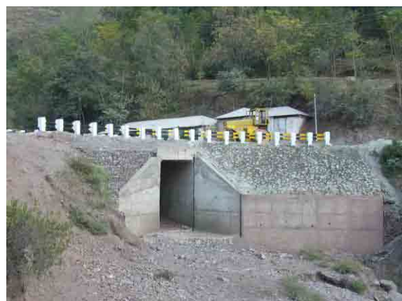
橋梁修復工事完成
