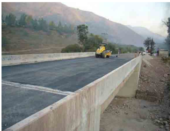
舗装工施工状況
