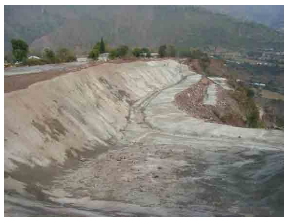
モルタル吹付け工及びコンクリート張工完了
