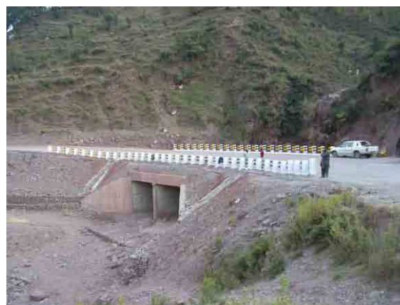
橋梁修復工事完成
