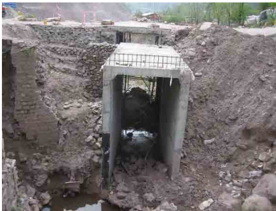
ボックスカルバート工完了
