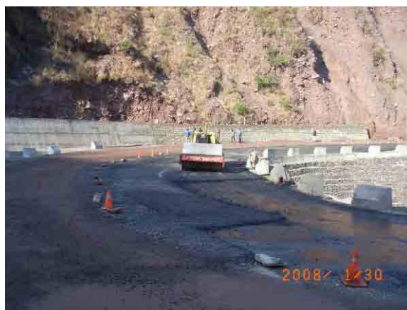
舗装工施工状況
