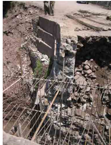
既設カルバート撤去工
