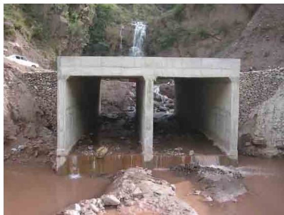
ボックスカルバート工完成
