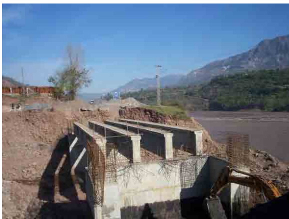
PC 桁架設状況
