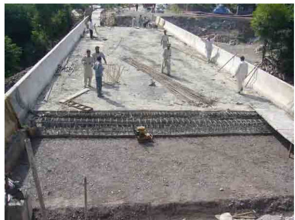
上部工施工状況
