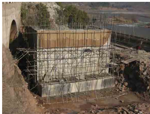
橋台施工状況
