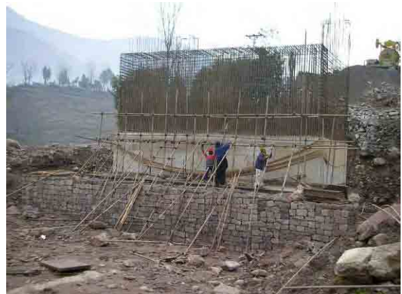
橋台施工状況
