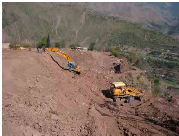
斜面上部掘削状況
