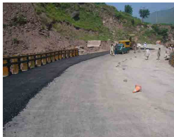
舗装工施工状況
