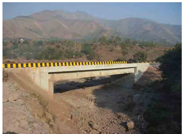
橋梁修復工事完成
