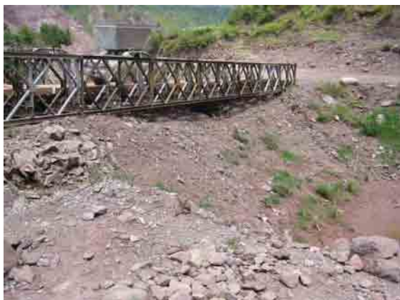
震災時の既設橋梁状況
