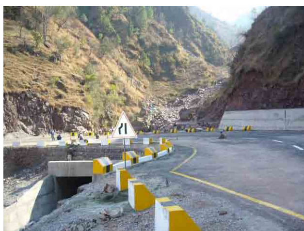
橋梁修復工事完成
