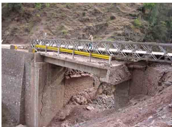
震災時の既設橋梁状況
