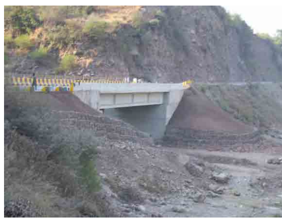
橋梁修復工事完成
