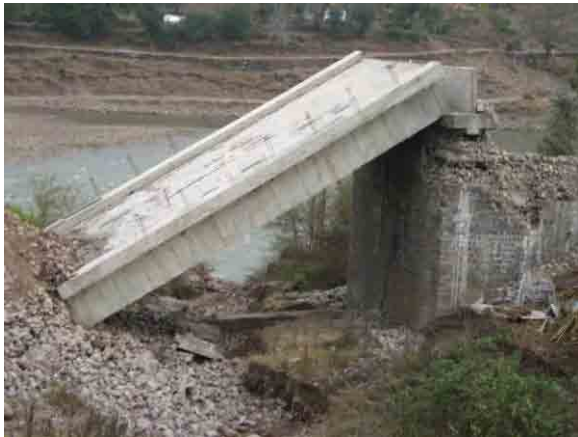
震災時の既設橋梁状況
