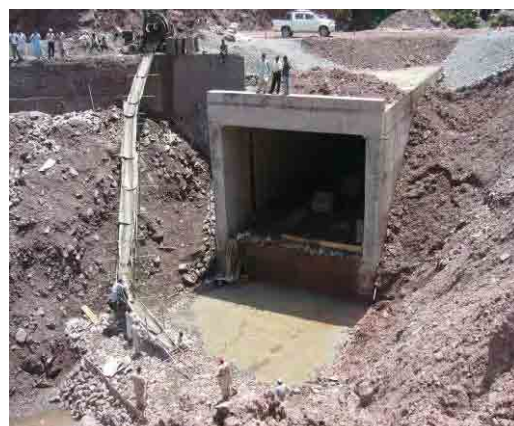
ボックスカルバート工完了
