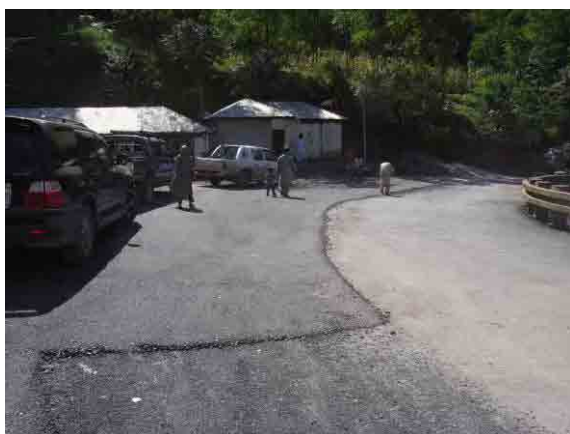
舗装工施工状況
