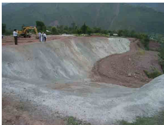
モルタル吹付け工完了
