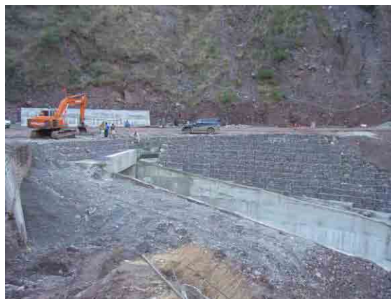
ガビオン擁壁工及び盛土工状況
