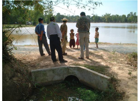
共有池（左）及び共有池と水路とをつなぐコンクリート構造物（右） （水路の先に水田があり、雨期には、池の中の魚が、水田と池とを行き来する。右下写真）
