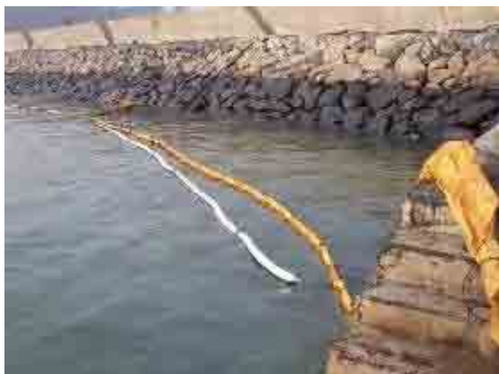
オイルフェンス展張状況
