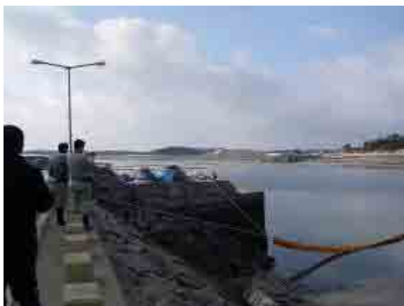
オイルフェンスの展張状況
