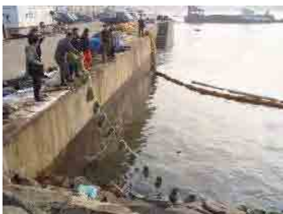
高粘度油専用油捕獲材の展張作業状況
