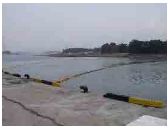
オイルフェンス展張状況
