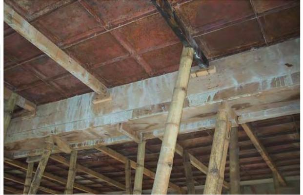
スラブ型枠に用いられている鋼製パネル。
