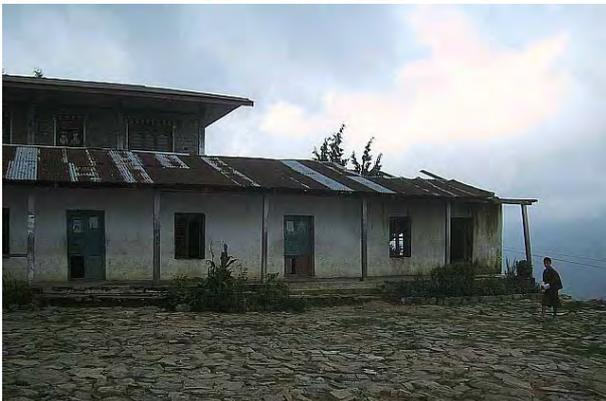
2007年4月の強風により損壊し、使用不可能となった校舎。
