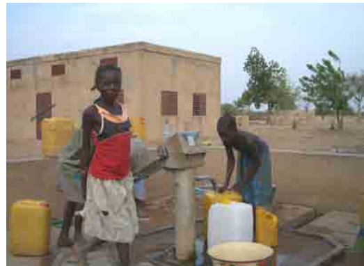
既存人力ポンプ付深井戸給水施設の状況①
