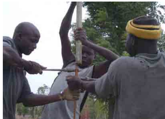
人力ポンプの修理状況
