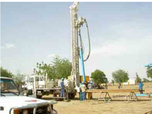
井戸掘さくの状況
