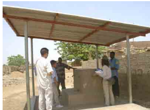
既存簡易給水施設の公共水栓
