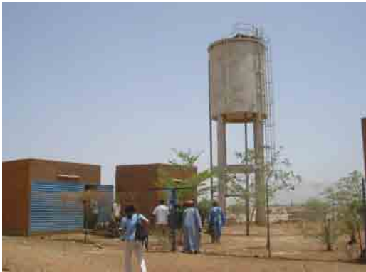
既存簡易給水施設の高架水槽と機械室
