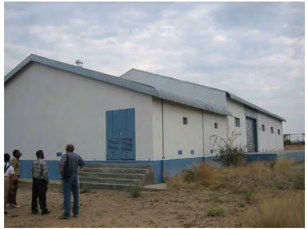
写真2 農薬倉庫。農薬防護服洗浄槽も内部に設置されている。(オカハンジャ倉庫)
