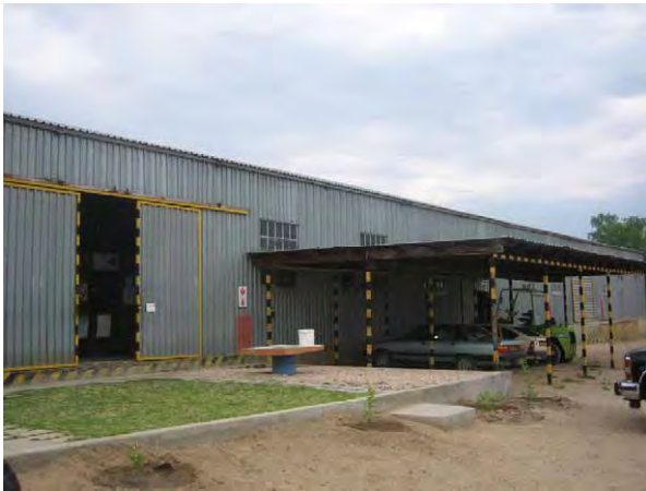
写真1 農業・水・森林省倉庫。農業資材・機材・部品の保管の他、販売も行っている。(オカハンジャ倉庫)
