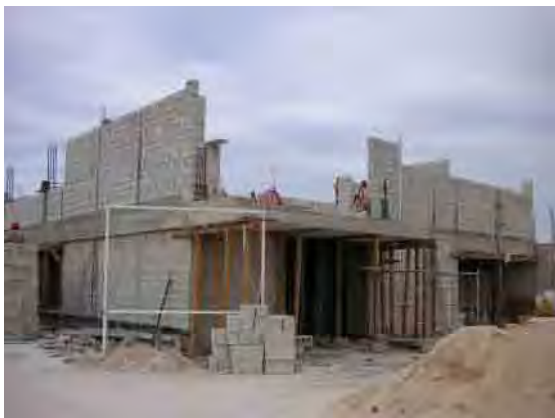
建設中のフィールドステーション。完成の暁には保護区保全の拠点として活用される予定。
