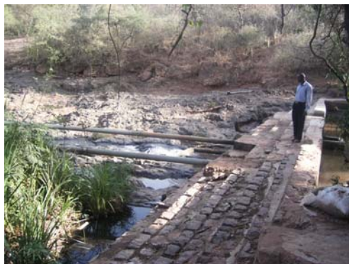
改修された堰と追加パイプ
