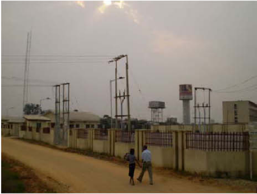
先方負担事項の様子(変電所)
