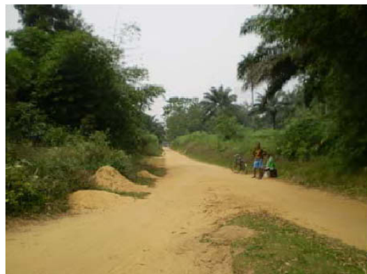
計画対象地域(配電ルート)の様子
