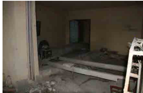
新蘇生室（改修工事中）
