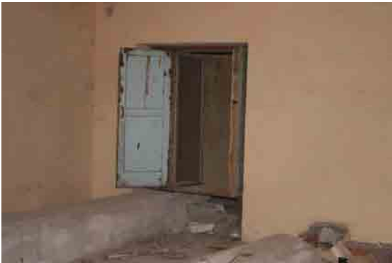
新蘇生室（改修工事中）
