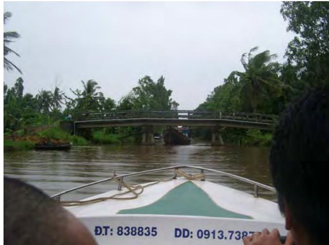
小規模な水路でも、通船のため橋桁と水面の間に 1.5～2.0 m の空間が必要となる。
