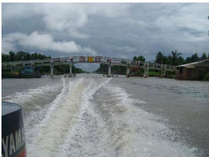
比較的幅の広い水路の橋梁。通船のため橋の桁下と水面の間に 2.8 m の空間が確保されている。
