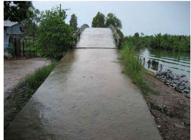
既存のコミュニティ道路 及び 橋梁の様子 要請されているコミュニティ道路の仕様は、幅 2.5m、コンクリート舗装である。
