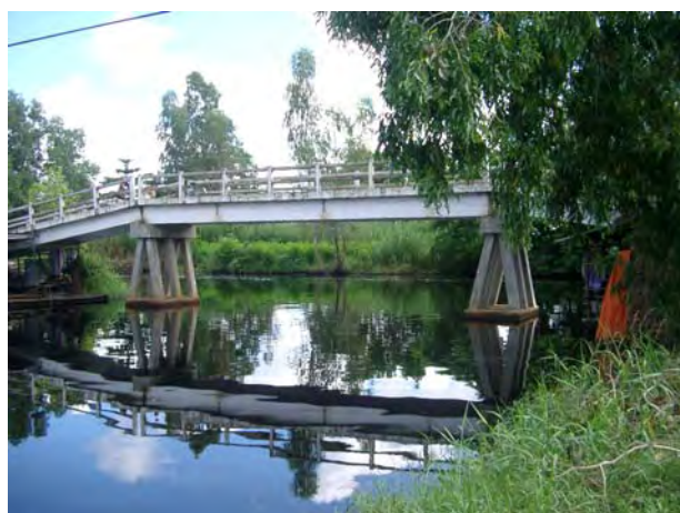
既存の橋梁の様子 本計画対象地域では水路が主要な交通手段となっていることから、船の往来を妨げないよう、水路を横断する橋梁の桁下は 2.0~2.5m のクリアランスを確保する必要がある。
