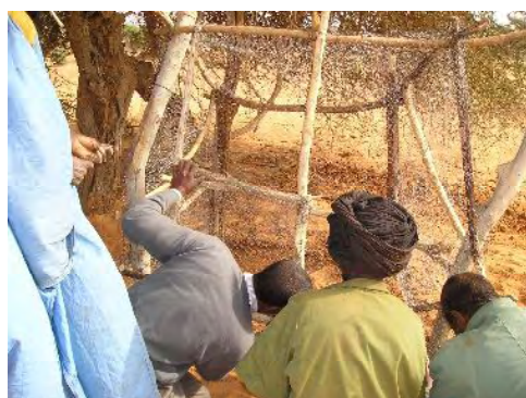
Cage en construction
