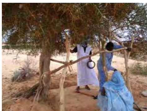
Construction de cage par les habitants
