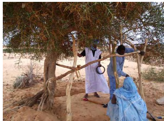
住民による鶏舎の建設
