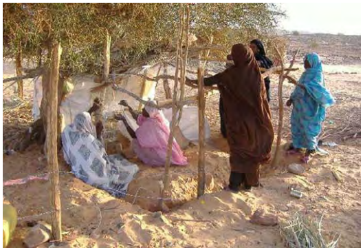
住民による鶏舎の建設
