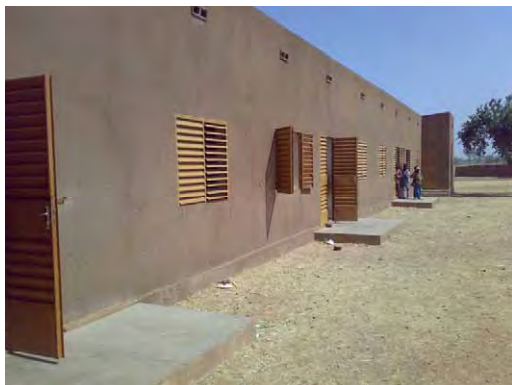
ベルギー援助による教室。施工品質は良い
