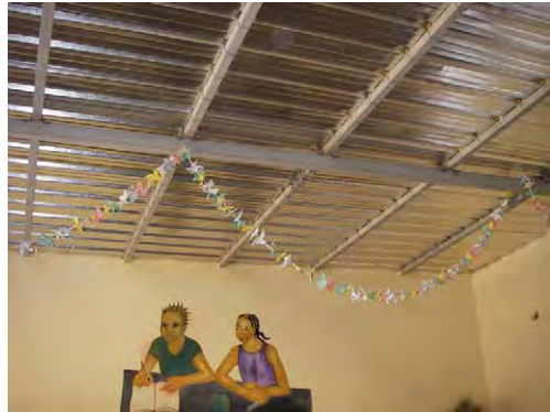
教室内部 (天井を見上げたところ)
