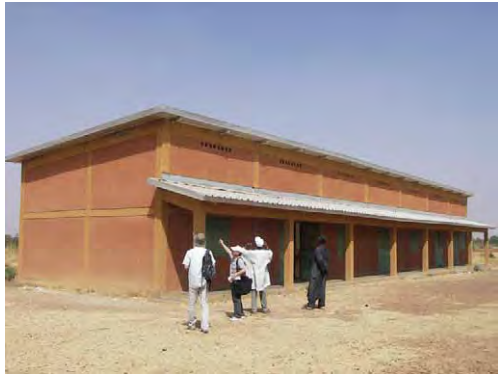
校舎の前面 (目だった傷みはない)
