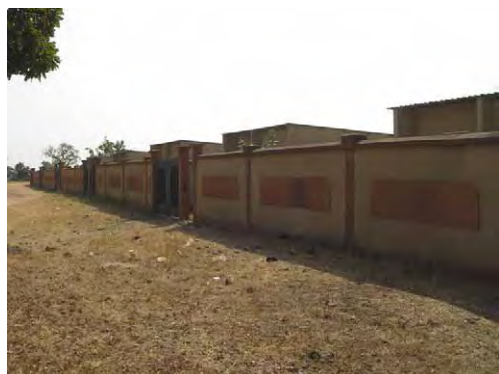
教員住宅 (6戸の教員住宅が並んでいる)
