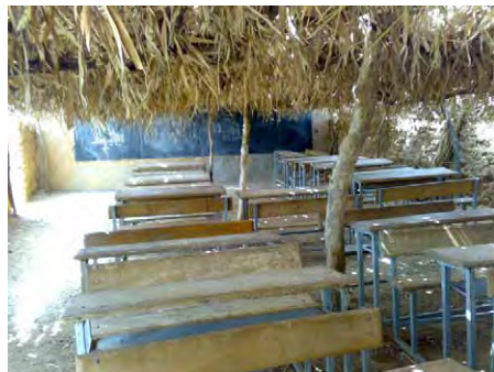
既存のわらぶき教室内部。比較的整然としている。
