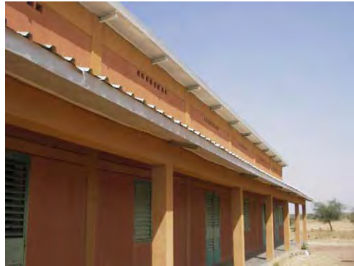
軒先を見上げたところ
