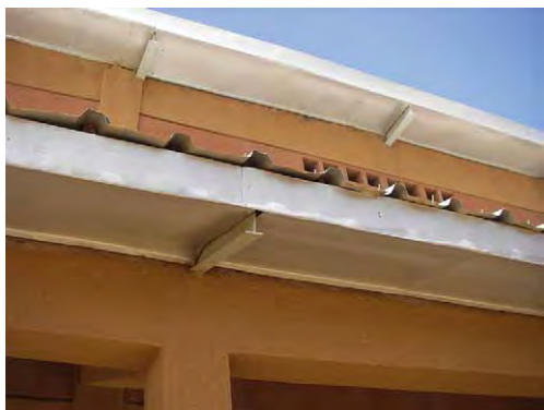
軒先の詳細 (金属加工が複雑である)
