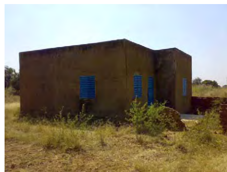
既存の教員住宅。
