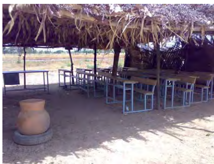
既存のわらぶき教室内部。
