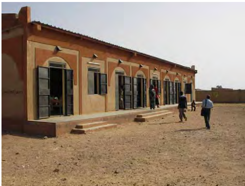
校舎の前面 (デザインと換気用ベントキャップ)
