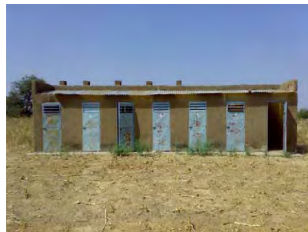
既存のトイレ。7ブース。
