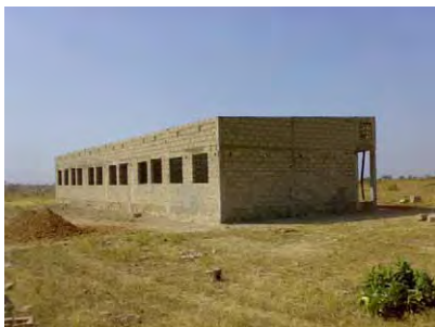
教室棟躯体。コンクリートブロックの枠組組積造
