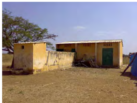
隣接倉庫施設。教員住宅として使用している。
