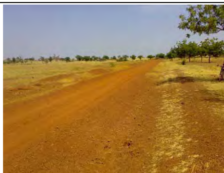
サイト前面道路。良好なラテライト舗装。
