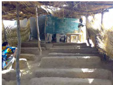
既存のわらぶき教室内部。
