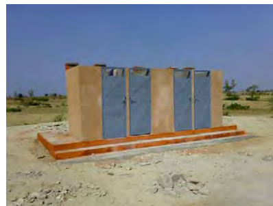
トイレ(4ブース) 屋根なし。
