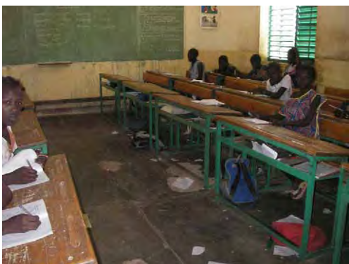
教室内 (床の破損が目立つ)
