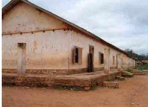
1979年 「カ」国政府により建設された教室棟
