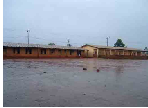
「カ」国政府により建設された教室棟
