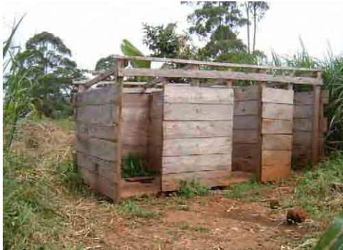
APEにより建設された木製の囲いによる便所
