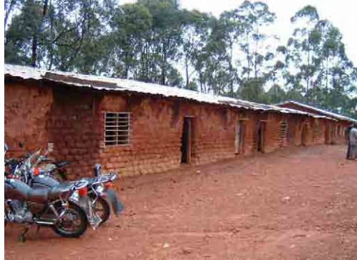
APEにより建設された土ブロック造教室棟
