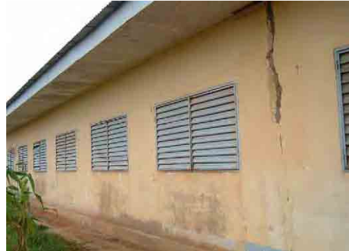
2004年BIPにより建設された教室棟
