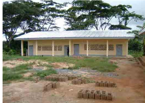
2006年 BIPにより建設された教室棟
