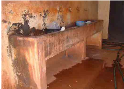
BID IIにより建設された便所棟手洗場
