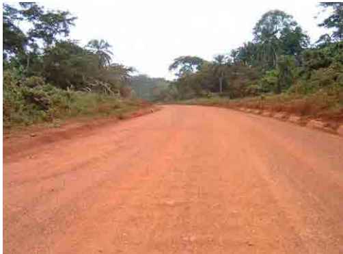
ヤウンデからベルトアまでの道（未舗装箇所）
