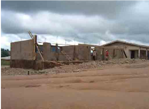
2007年4月の竜巻被害で建替、改修工事中
