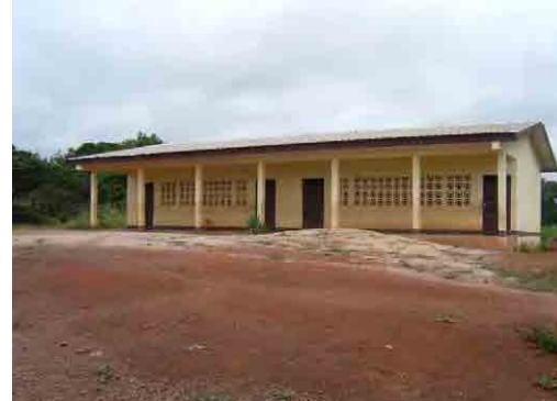
2003年 PSTEにより建設された教室棟
