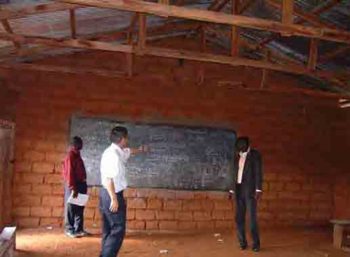
APEにより建設された土ブロック造教室内観
