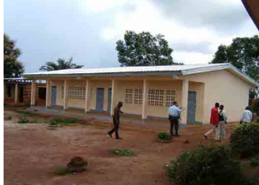
2006年 BIPにより建設された教室棟
