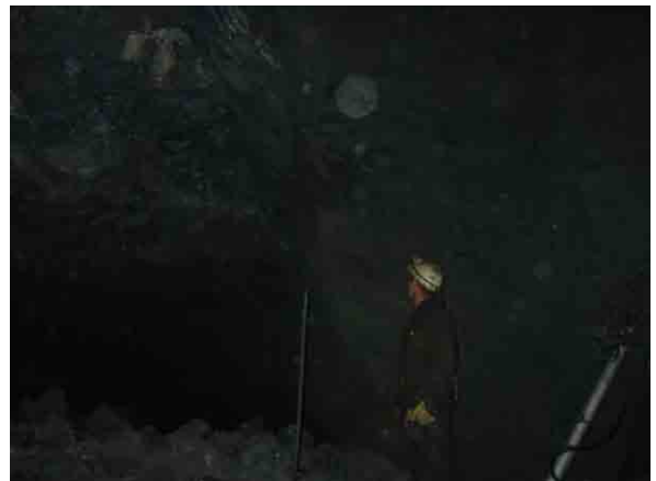
暗い切羽で浮石払いをする労働者。
