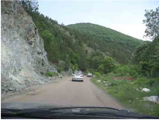
国道から鉱山には舗装道路が 6Km 続くがこれは、鉱山が建設した。
