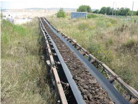
採掘された石炭は発電所までベルコンで直送される。
