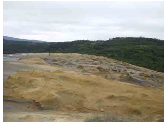
廃滓堆積場堤体の浸食状況
