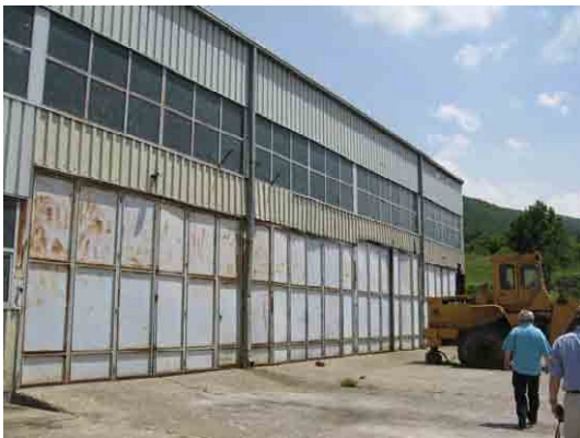
ピットから比較的傍に機械修理ピットがあった。
