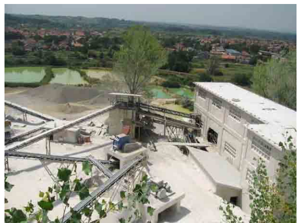
色々な粒度にする破碎工場の概観と洗浄した汚濁水を清浄させる沈殿地。
