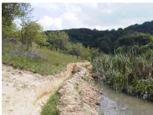
Grot 鉾山廃滓堆積場周囲の側溝(素堀)
