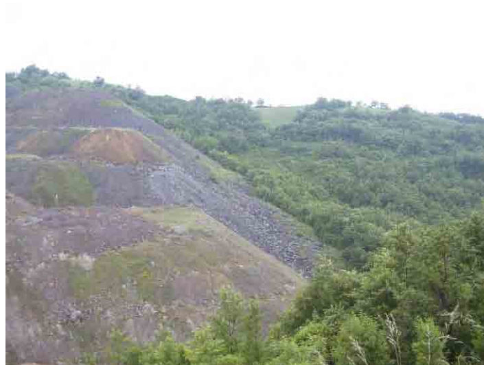
Kizevak 鉾山廃石堆積場
