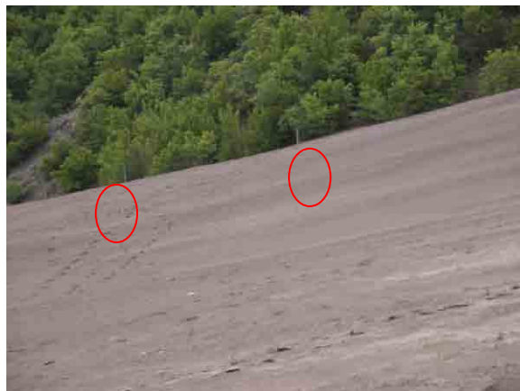
Kizevak 鉱山新廃滓堆積場堤体に設置された水位観測井
