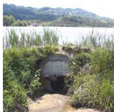
Grot 鉾山廃滓堆積の集水管
