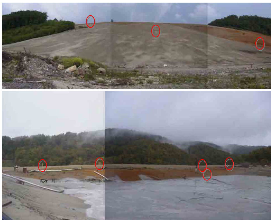
Rudnik 鉱山の廃滓堆積場(上:外側概観 下:内側概観 円内は観測井戸)
