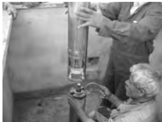
水中モーター・ポンプの設置
