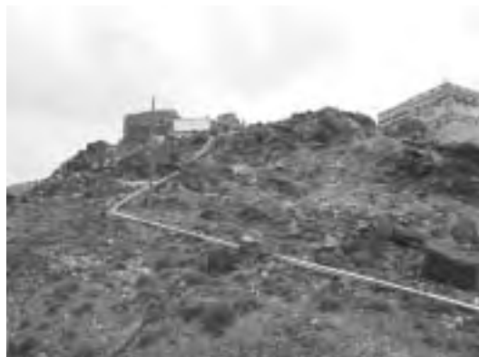
敷設された導水管と配水管
