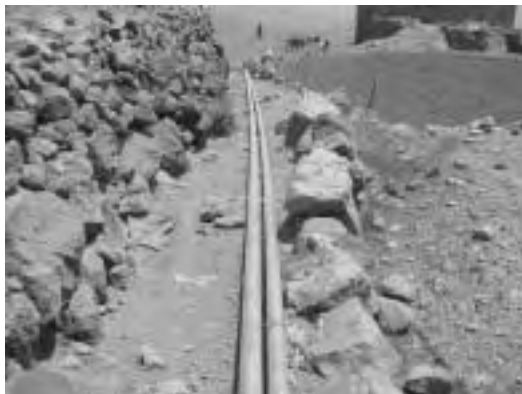
導水管(左)と配水管(右)
