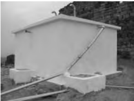
改修された地上型貯水槽 (25m³)
