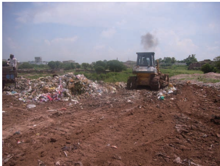
ラワルピンディの最終処分場（無償供与ブルドーザーで頻繁に覆土されている）
