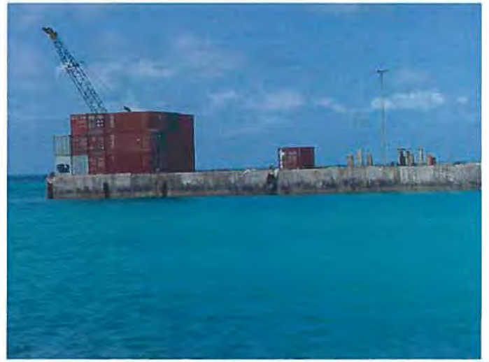
-6m岸壁全景
