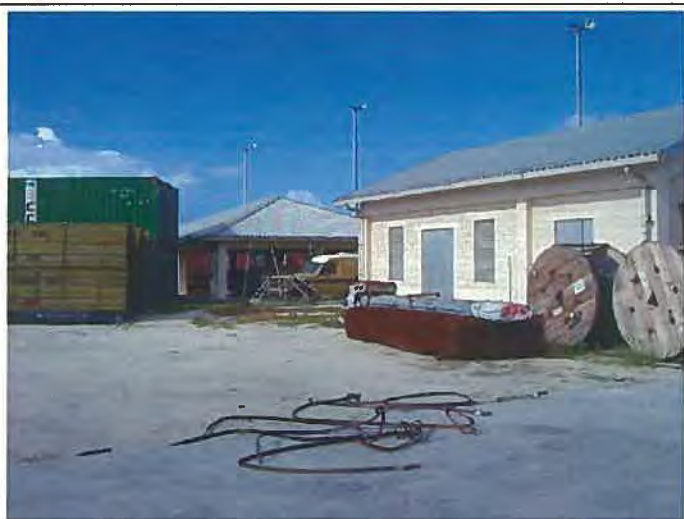
使用されていない旅客ターミナル及び発電設備
