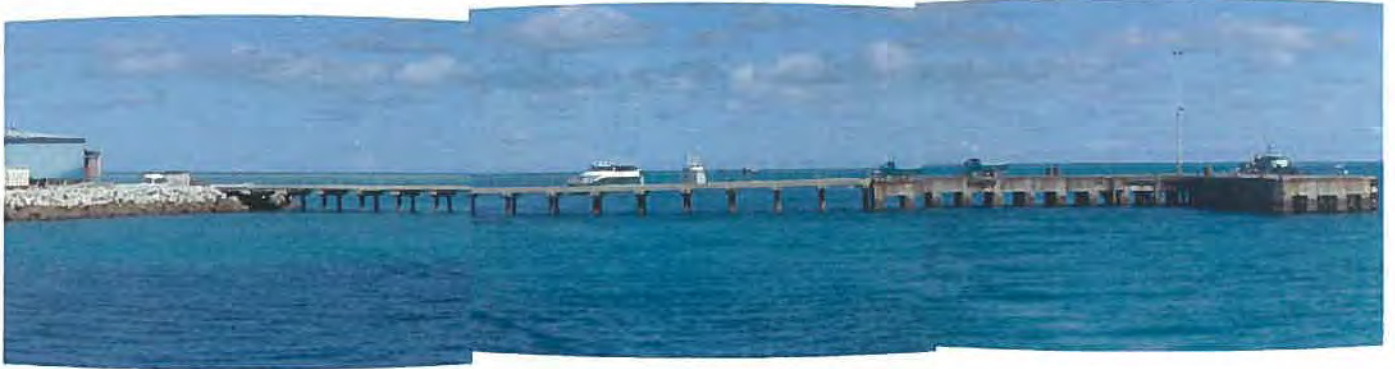
-6m 国内貨物用棧橋（旧漁業棧橋）全景
