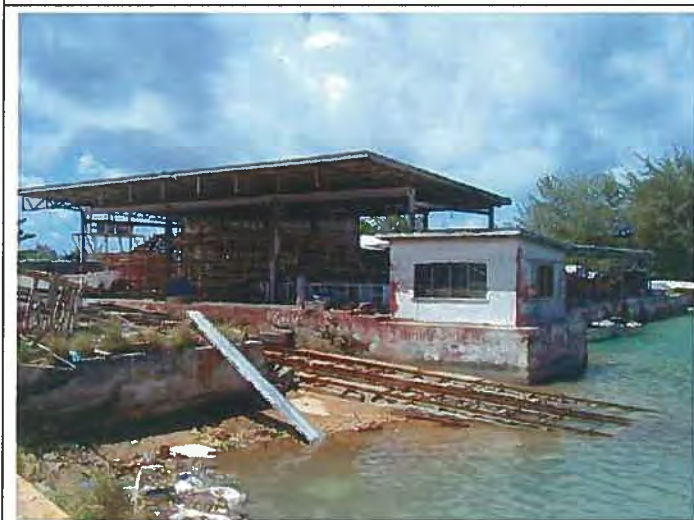
旧港対岸、シップヤード斜路
