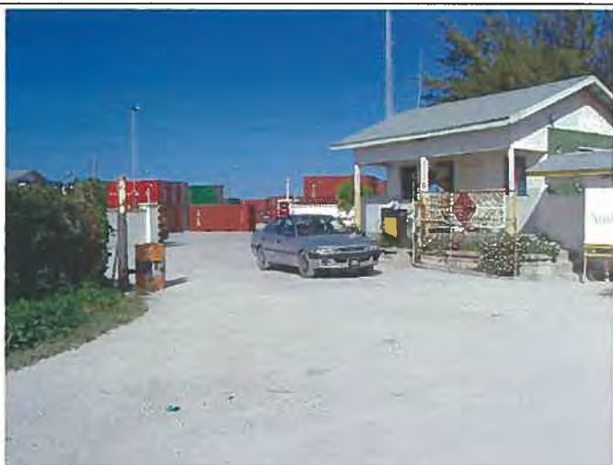
西側新港進入ゲート
