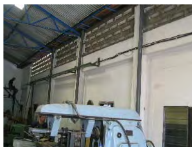
ケーブルラックの新設
