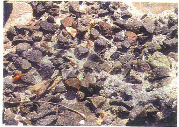
現場視察（キューブ型消波ブロック表面）
