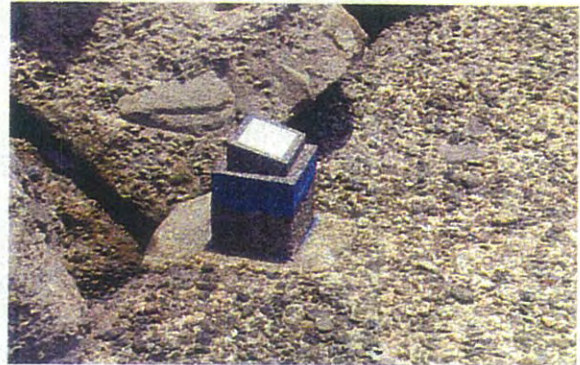
現場視察（防波堤上測位ステーション）
