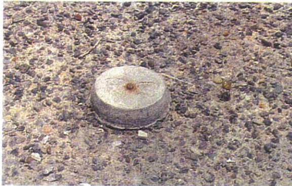
現場視察（防波堤上部コンクリート上水準点）
