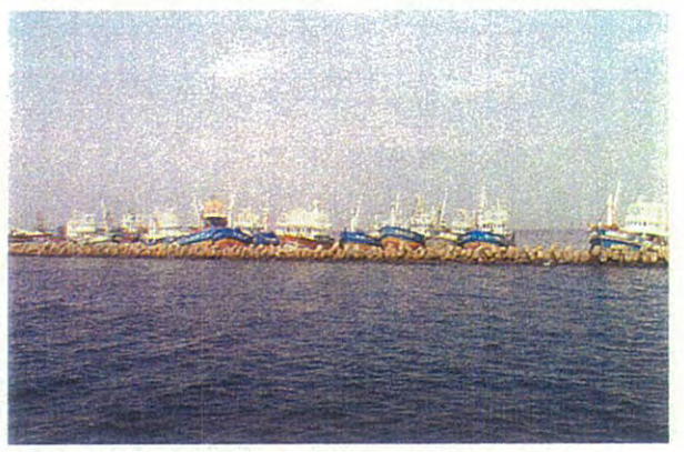
現場視察（防波堤現況）
