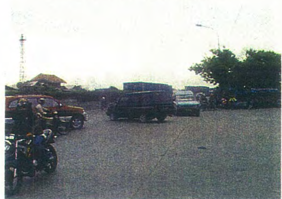
現場視察（フライオーバー建設予定地）
