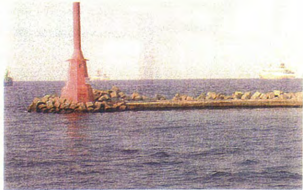
現場視察（防波堤堤頭部現況）
