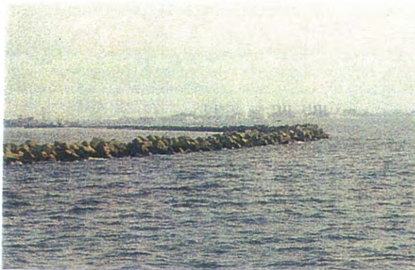
現場視察 (防波堤現況)
