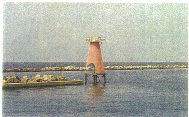
現場視察 (防波堤現況)
