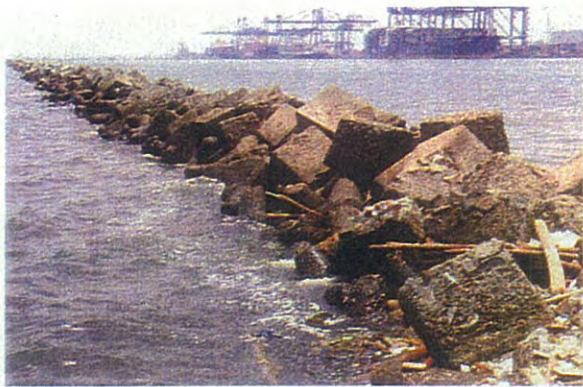
現場視察（防波堤現況）
