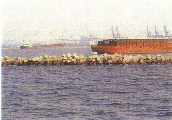
現場視察（防波堤現況）
