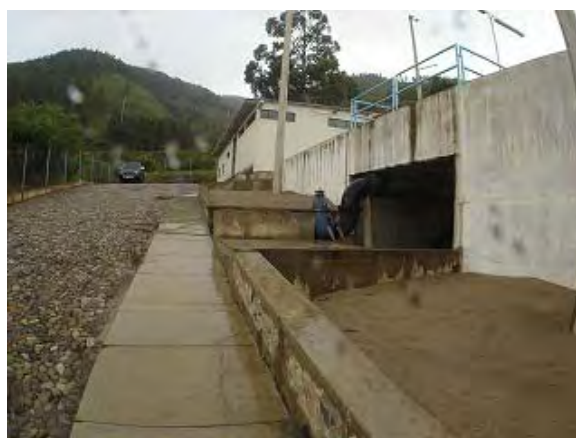
アランフェス浄水場、ろ過池増設予定地。
