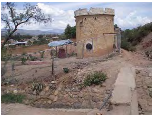
水組合の給水施設。井戸及びポンプ設備からなる。
