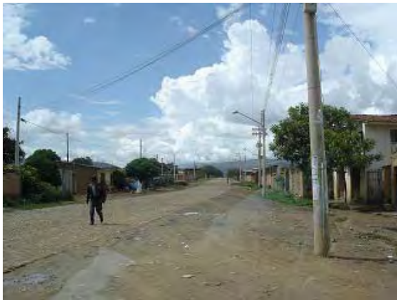
典型的な第1配水区の街並み。幹線道路はアスファルト舗装であるのに対し、地域内の道路はほとんど石畳である。
