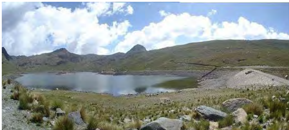
アランフェス浄水場の水源であるワラワラダム。今期は、雨量が少なく貯水量は少ない。 (2007年2月)
