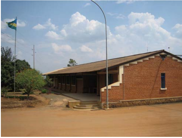
写真1： 2KRの実施に際し、販売や普及活動の中心機関となる予定のルワンダ農業開発公社（RADA: Rwanda Agriculture Development Authority）。
