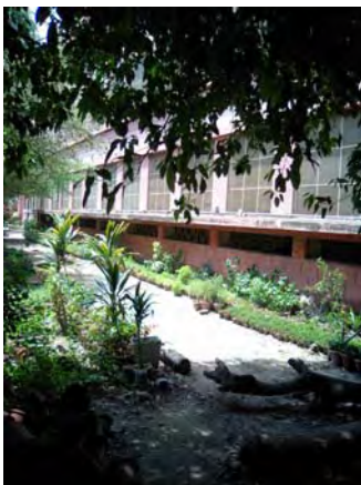
ニシタール医科大学外観。外部には 地下への通路もあり外側への拡張に は困難も想定される。
