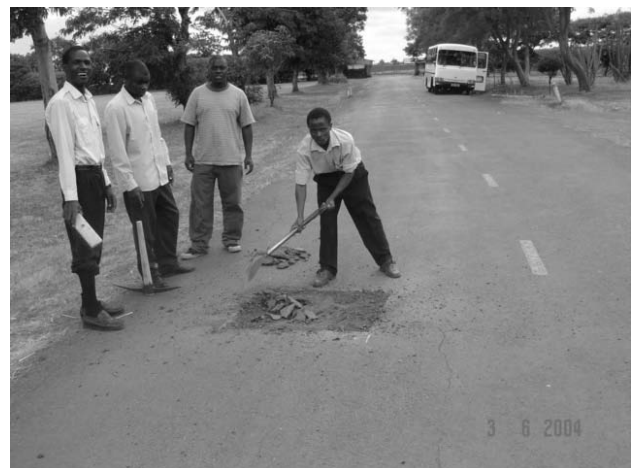
道路舗装補修の実習
