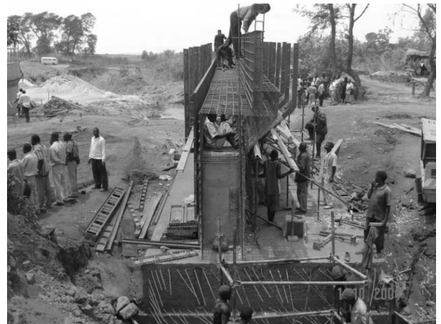
現場実習・型枠鉄筋講習
