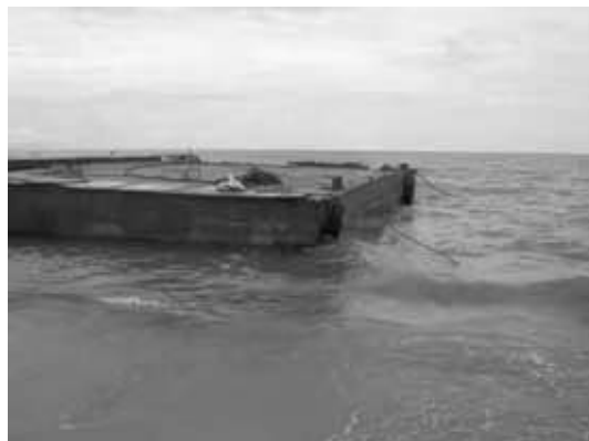
P88 ポンツーンはワイヤーで係留されている
