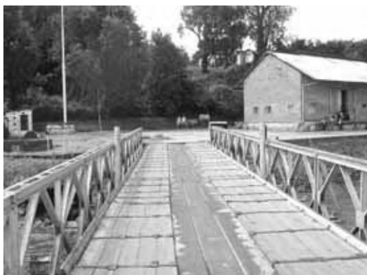
P69 浮き桟橋から構内を望む
