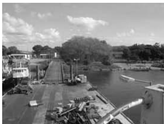
P108 修理中の Ilala から見た Monkey Bay、浮き栈橋入り口の連絡橋
