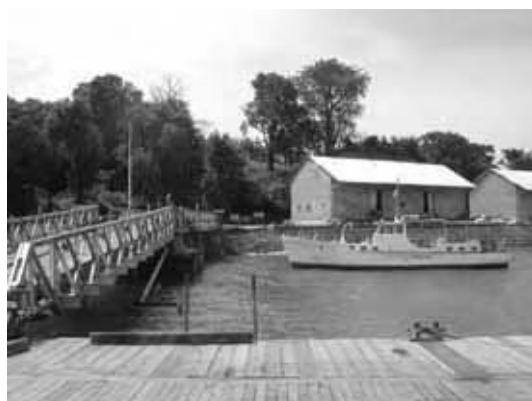
P72 浮き桟橋より構内・倉庫を見る
