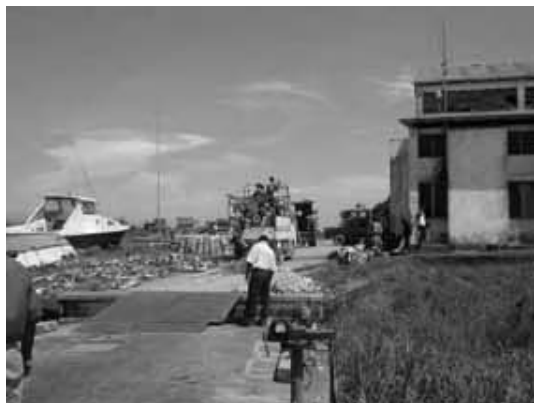
P25 浮き栈橋の入り口と 管理事務所(右の建物)
