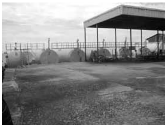
P52 港に併設されたオイルタンクデポ
