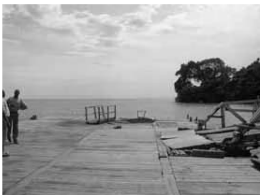
P71 浮き桟橋上にて
