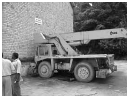
P75 稼働中のモバイルクレーン
