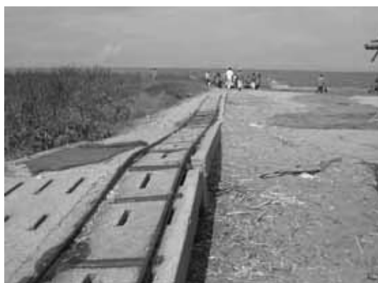
P89 精糖工場から港まで引かれていた 台車用レール
