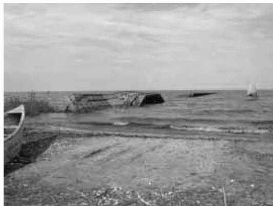
P92 支柱が腐食崩壊しレールは 全く使い物にならない
