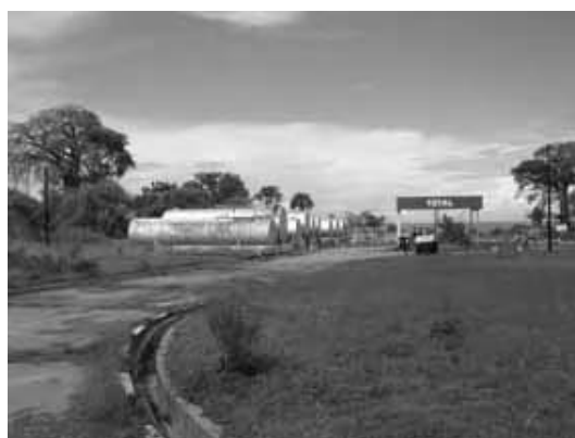
P12 港から数十メートル離れたオイルタンク
