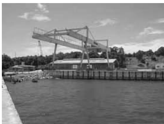
P39 岸壁・ガントリークレーンと倉庫
