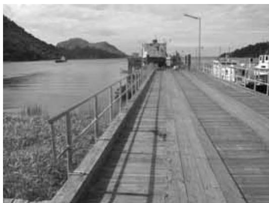
P102 浮き栈橋につながる連絡橋
