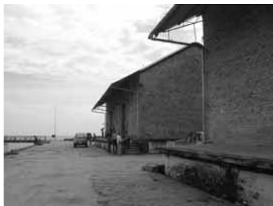
P74 港構内の倉庫
