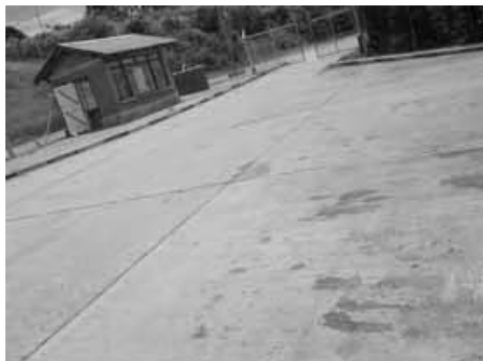
P49 構内から守衛所入り口を見る
