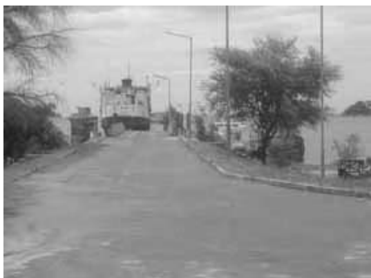
P99 浮き栈橋への通路
