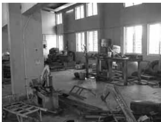
P27 修理工場内風景
