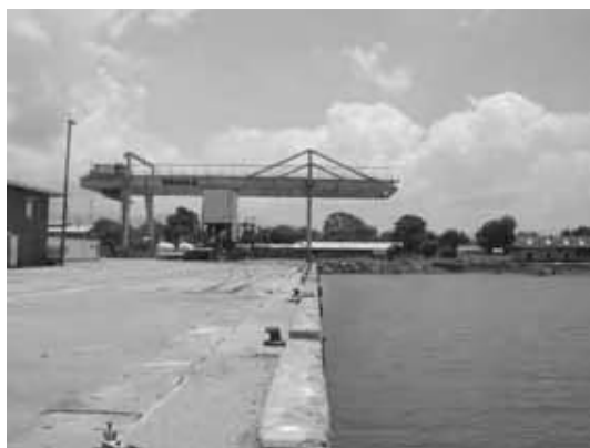
P5 岸壁とガントリークレーン
